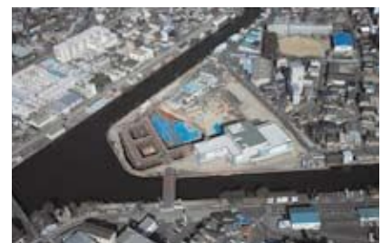
露橋水処理センター（建設中）
