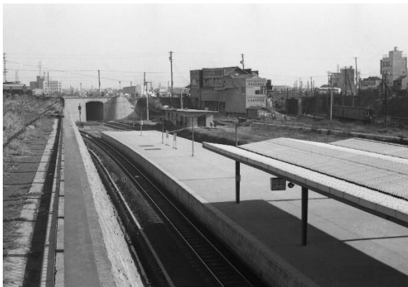
完成当時の中央本線金山駅ホーム
