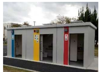
■車いす対応トイレ（中川区八家公園）
