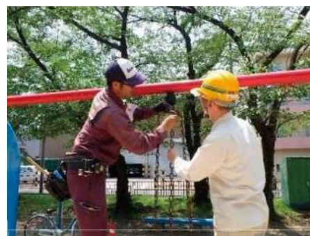
■遊具の点検（熱田区桜田公園）
