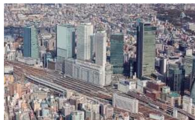
名古屋市内では各所で再開発が進行中だ。名古屋駅地区では高層の複合ビルが整備され、高まる企業のオフィス需要に対応する。
