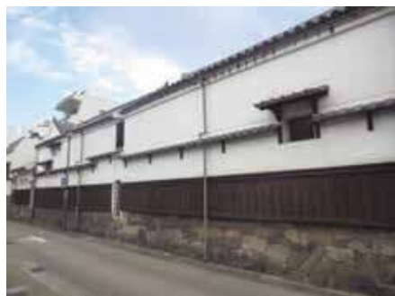
四間道 伊藤家
