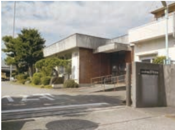
西土木事務所
