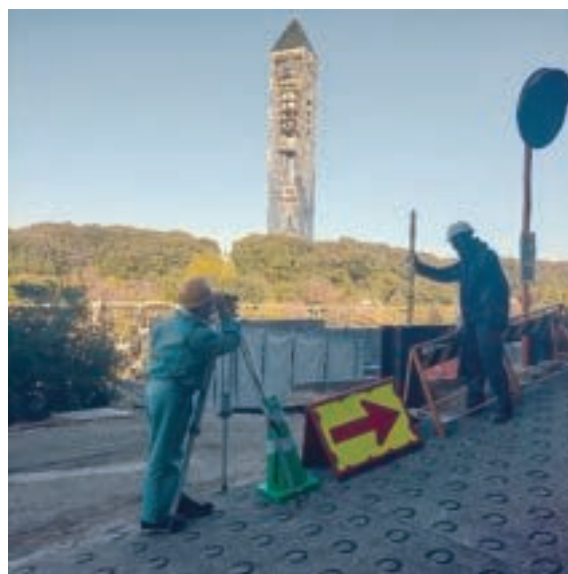
工事完了検査の様子・現場
