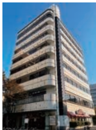
江川線整備事務所を設置したビル
