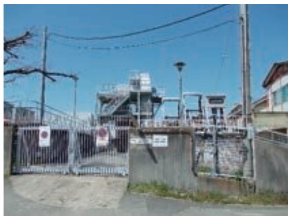
支障となった下之一色ポンプ所
