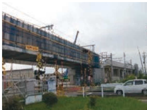
国道302号喜多山2号踏切(北側)
