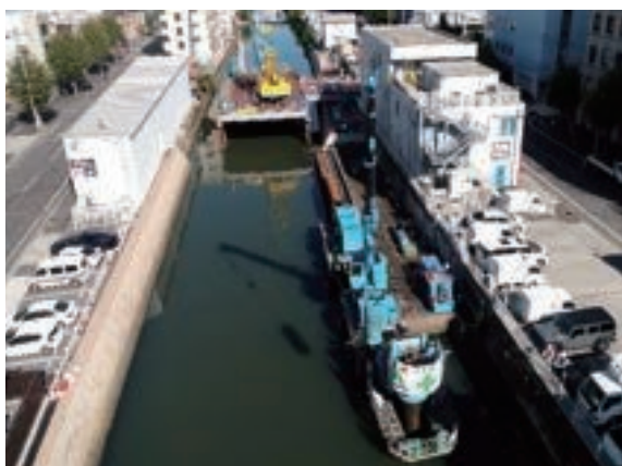
堀川における護岸工事の様子
