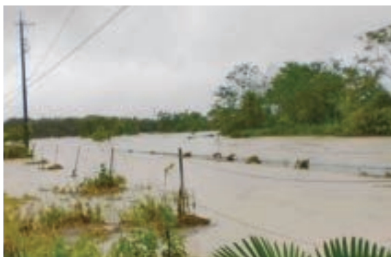
守山区野添川の被災状況
