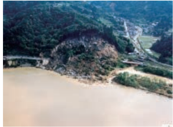
一般県道小千谷長岡線の土砂崩れ
