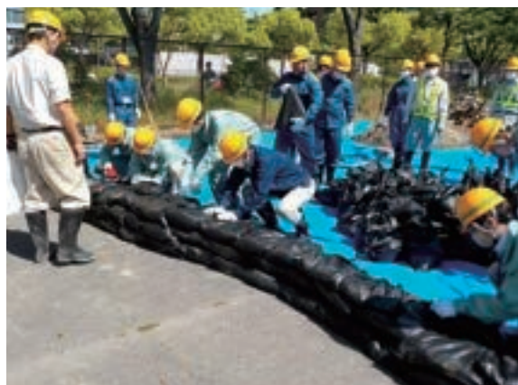
土のう積み作業状況
