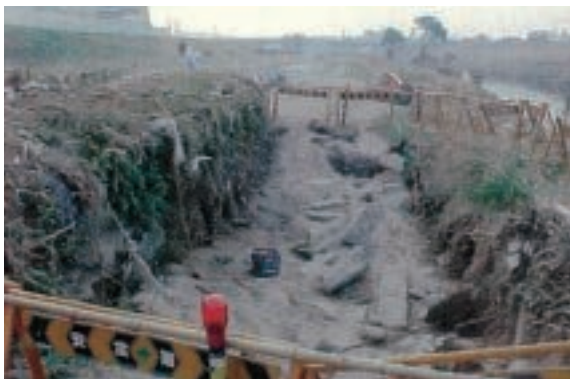
西区庄内緑地の被災状況
