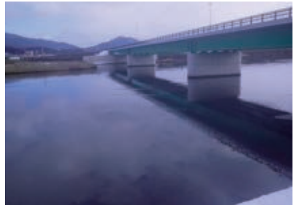
姉齒橋の完成状況
