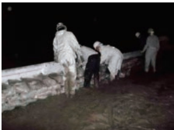
職員による応急対応状況
