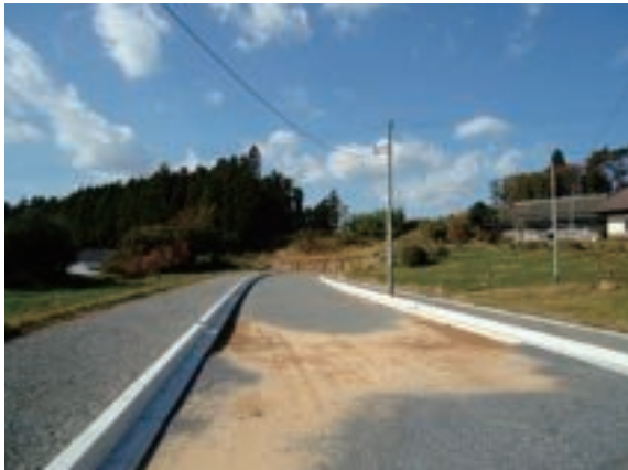
高田米崎間道路の整備状況
