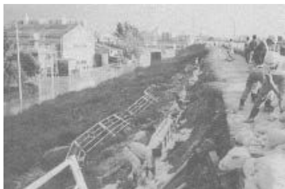
天白区井の森付近の天白川左岸堤防
