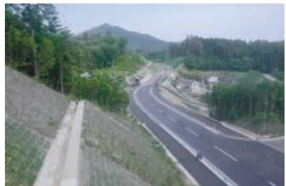
高田米崎間道路の完成状況
