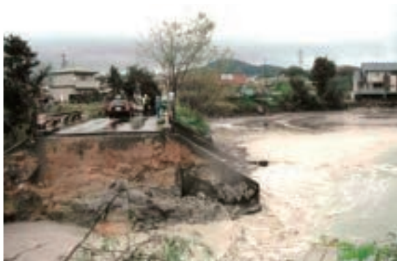
守山区カケヒ池の被災状況
