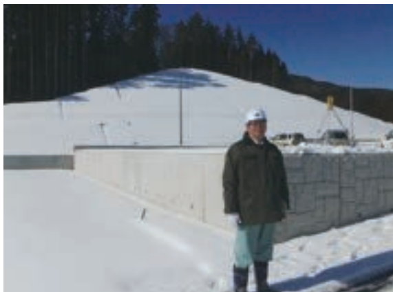
防災集団移転促進事業に伴う 道路築造・土地造成に従事する派遣職員①
