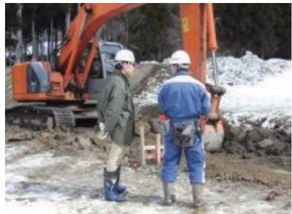
林道整備の現場に立会う派遣職員
