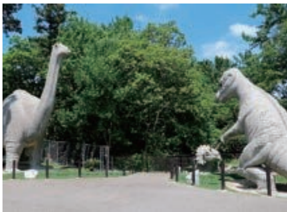
補強・補修完了直後の恐竜像
