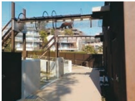
屋外運動場をつなぐ空中通路
