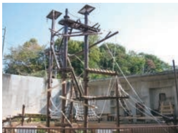
チンパンジータワー
