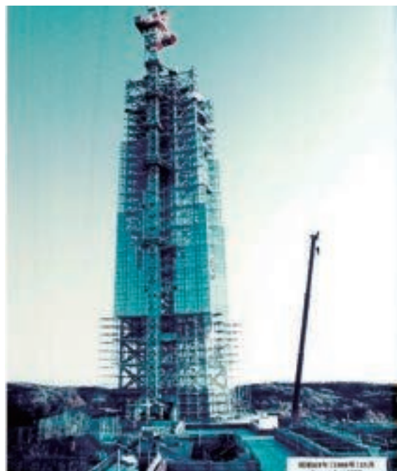
建設中の「東山スカイタワー」
