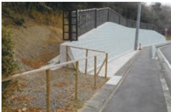
がけ崩れ対策(明德公園)
