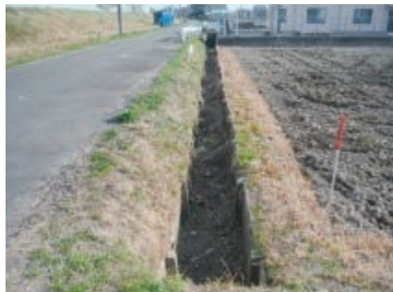
農業用水路(更新前)
