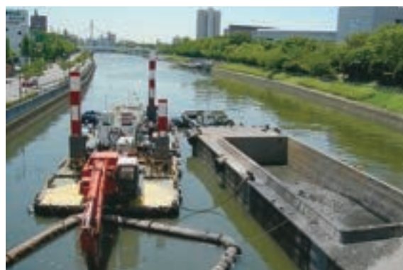
河道掘削に合わせたヘドロの除去
