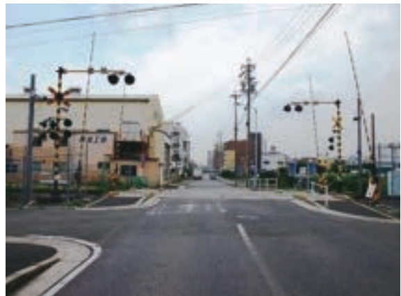
三番通踏切(拡幅後)
