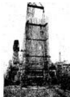
地中連続壁基礎の施工状況
