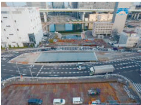
Ⅱ期施工の状況
