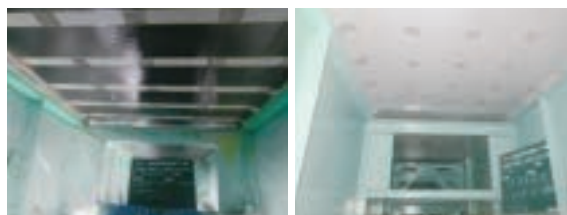
炭素繊維シート工法
