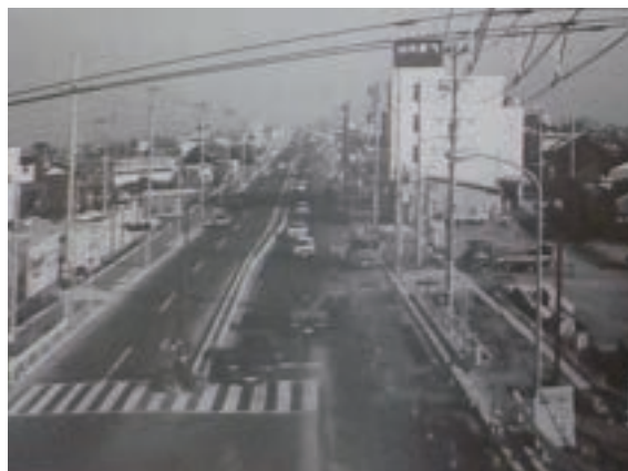
東海橋線(昭和59年12月)
