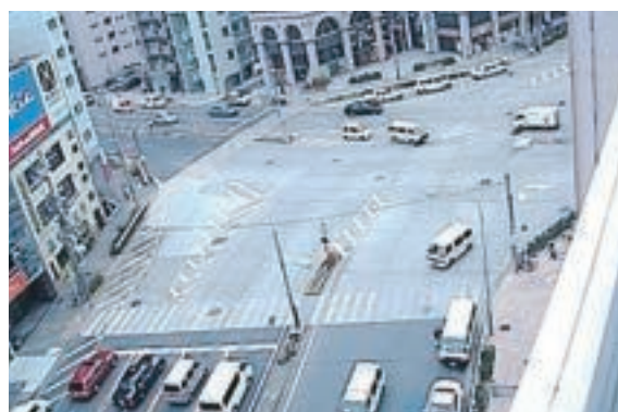
写真1 千郷町交差点(工事前)
