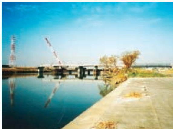
横井大橋(上部工架設状況)
