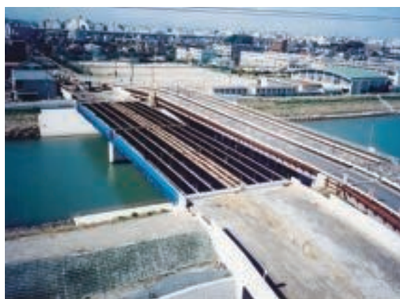
星園橋の施工状況
