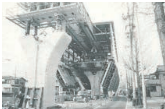
大型移動支保工移動状況
