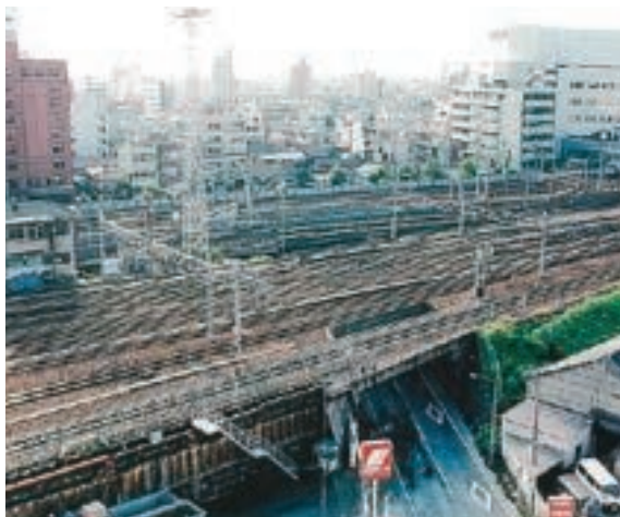
清正公架道橋(工事着手前)
