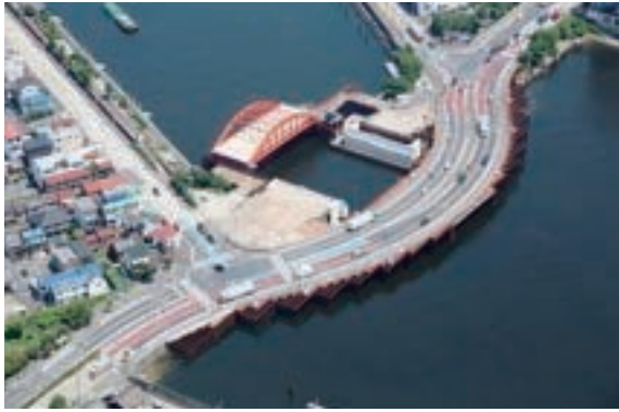
施工状況(アーチ仮置き)
