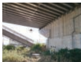
ドローンによる点検
