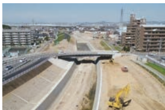
改築後の御幸橋
