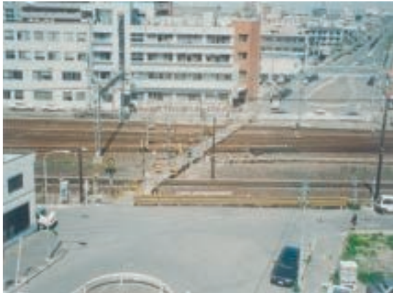
白山・八田4号踏切(着工前)
