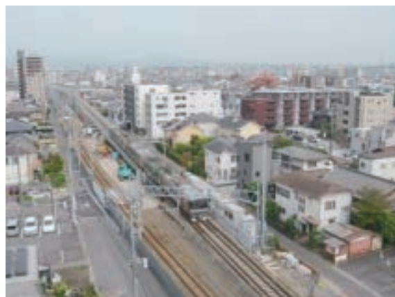
上り線高架切替後
