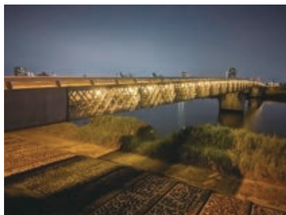
改築後の正徳橋
