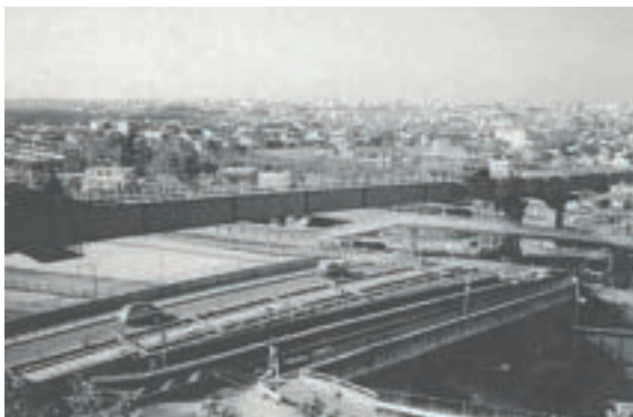
施工完了(一括吊上げ工法)
