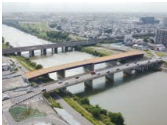
枇杷島橋の施工状況 (R4.6)
