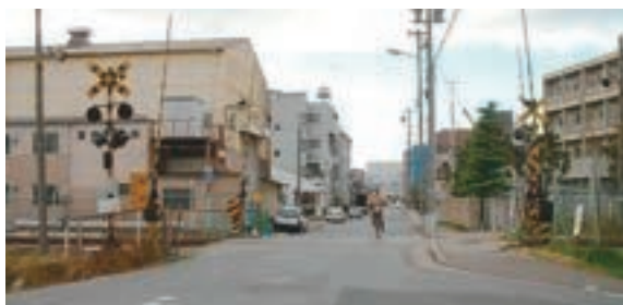
三番通踏切(拡幅前)
