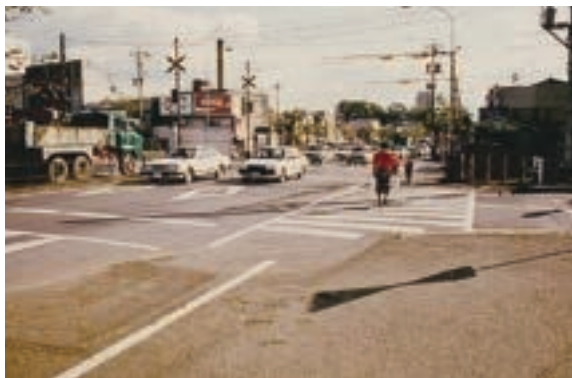
国道41号(事業前)
