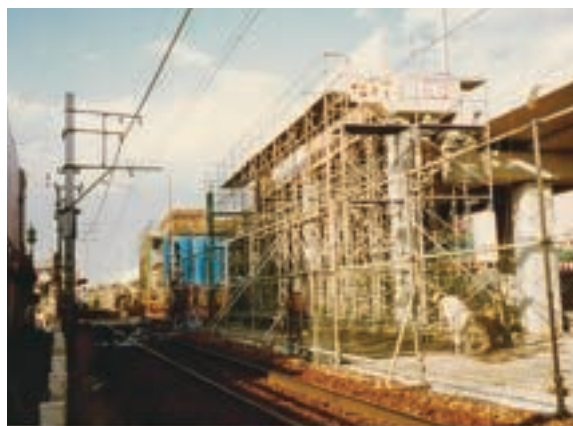
名鉄常滑線(新堀川～山崎川)事業中状況
