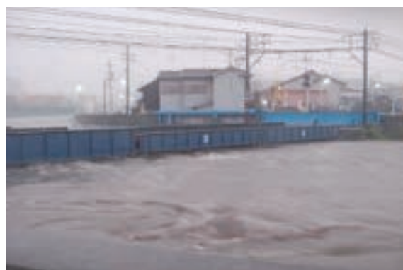
陸閘門(名鉄名古屋本線橋梁)
