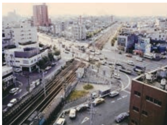
森下駅・国道19号(事業前)
