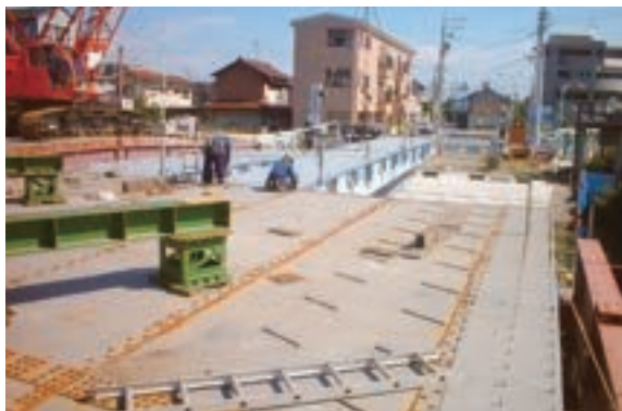
上部工架設状況
