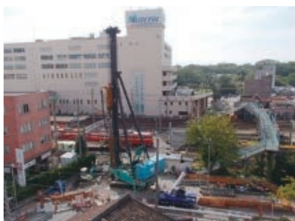
御田跨線橋 事業中
