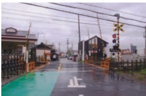
戸田第1号踏切(拡幅後)
