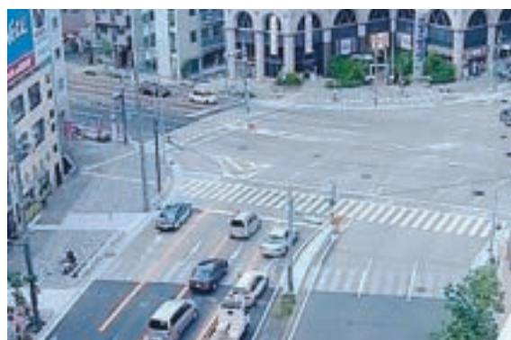
写真2 千郷町交差点(工事後)
