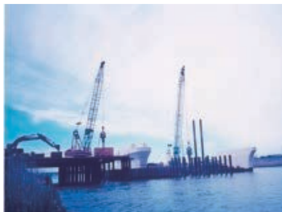
下部工施工状況(陸上+水上同時施工)
