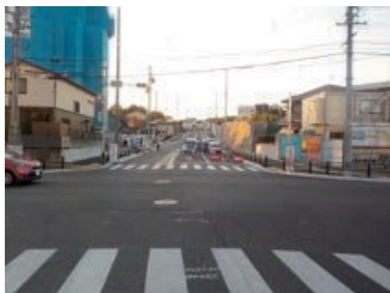
整備後(令和3年11月)
