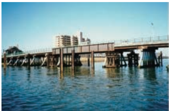
橋脚を撤去し支間長を拡大
