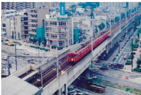
国道19号交差部(高架化後)
