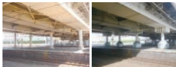
熱田陸橋の耐震補強
