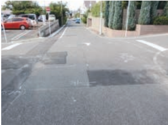
道路復旧工事前(仮復旧)
