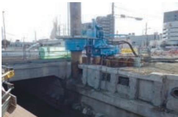
ジャイロパイラーによる縁切り
