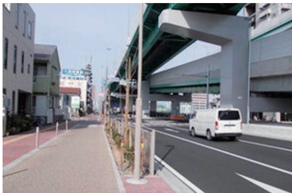
江川線：整備後
