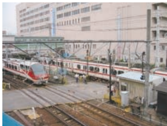
御田跨線橋 着手前
