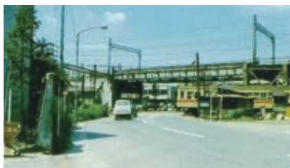
工事着手前の秋葉踏切
