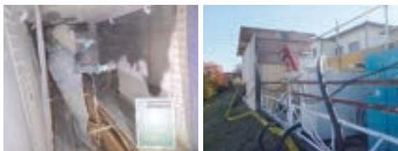
循環式ブラスト施工状況
