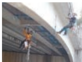
ロープを用いた高所作業
