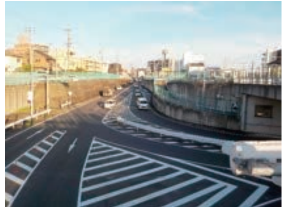
堀越天神橋線と守山本通線の接続部
