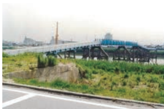
改築前の正徳橋
