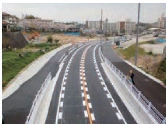
開通後(令和5年3月)
