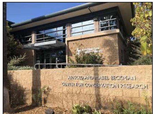
【センターの外観】
