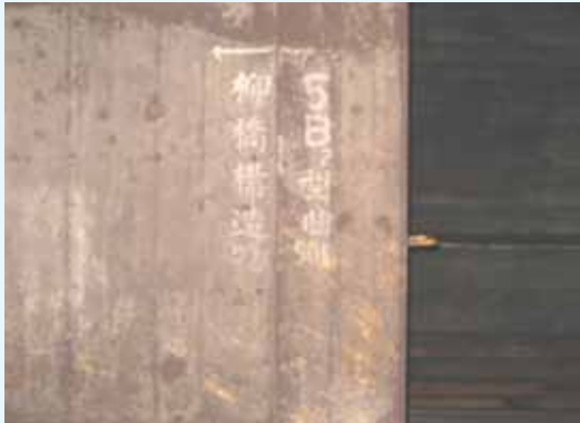
トンネル内の「柳橋構造物」の標記
