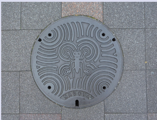
本市の下水道マンホールふた
