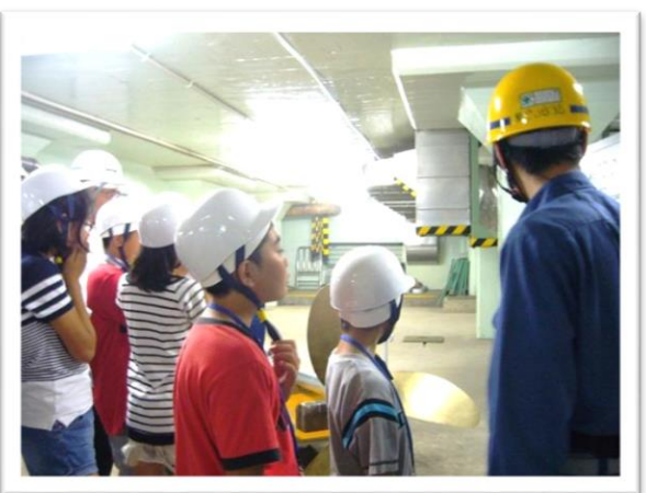
① 反応タンク はんのう (微生物 びせいぶつ がいるタンク)の見学
