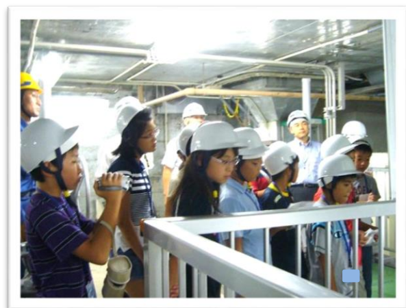
① ろ過装置 かそうち の見学
