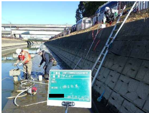
作業状況（河川側より撮影）
