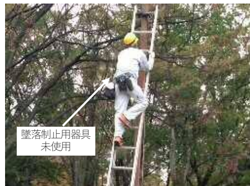
作業状況（拡大）
