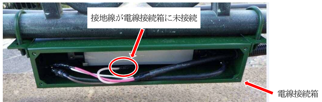
電線接続箱（端部）の状況
