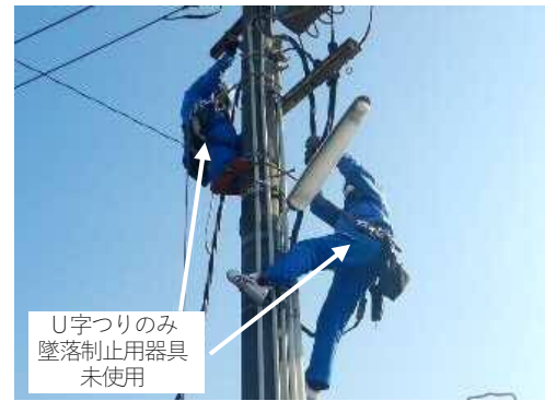
作業状況（拡大）
