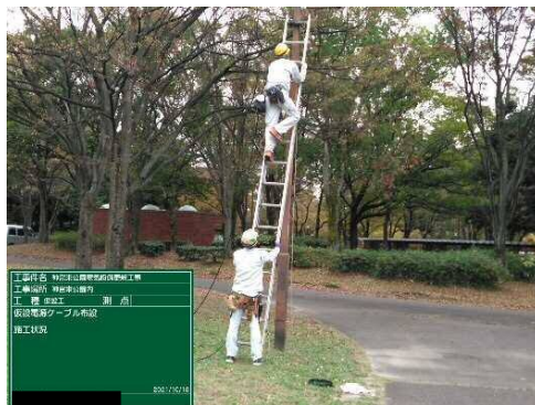
作業状況（高さ約3.5m）
