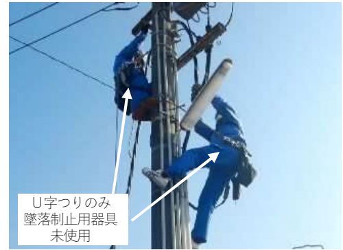
作業状況（拡大）
