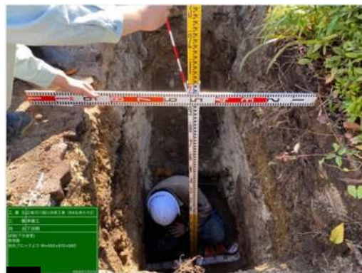
作業状況（深さ 1.9m）
