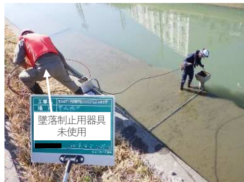
作業状況（高さ約2.3m）
