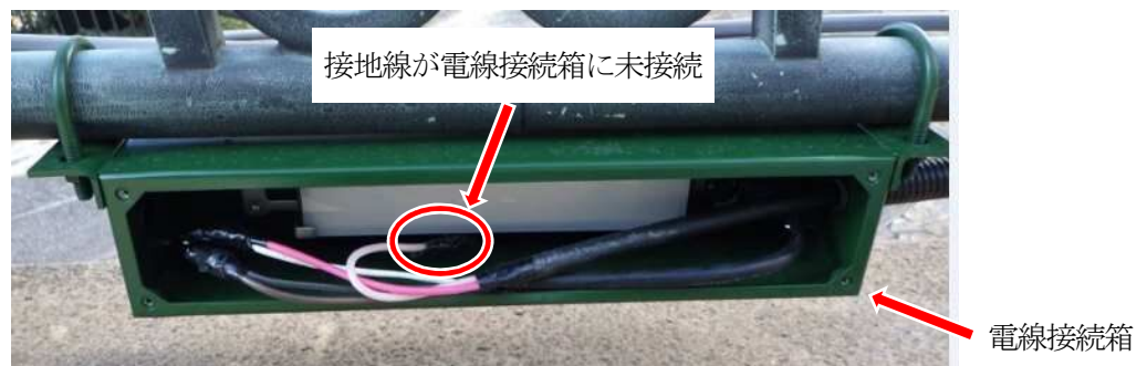
電線接続箱（端部）の状況
