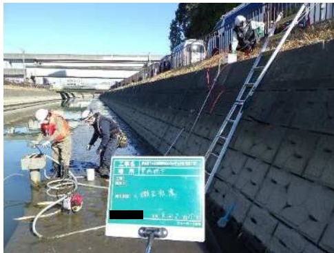
作業状況（河川側より撮影）
