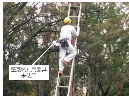
作業状況（拡大）
