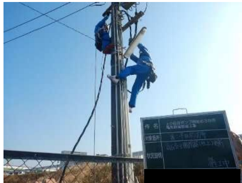
作業状況（高さ約 5.0m）
