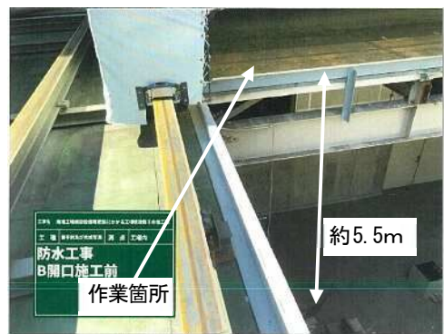
作業場所（高さ約5.5m）
