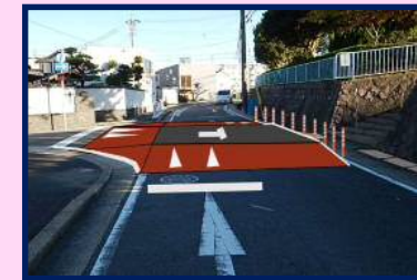
●交差点ハンプ設置
