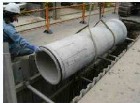
下水管の改築 (45km/年)
