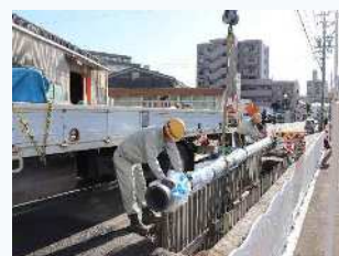
配水管の更新 (102km/年)
