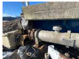
令和6年能登半島地震における水管橋の破断(左)とマンホールの浮上(右)の状況
