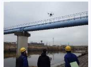
ドローンを活用した水管橋の点検
