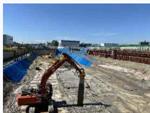
春日井浄水場凝集沈澱池の更新工事
