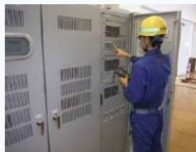
電気設備の点検
