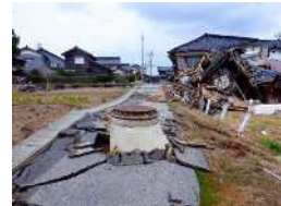
令和6年能登半島地震における水管橋の破断(左)とマンホールの浮上(右)の状況
