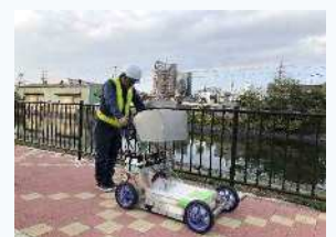
路面下の空洞調査 (140km/年)
