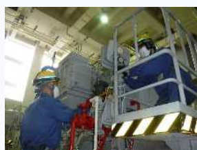
雨水ポンプの点検
