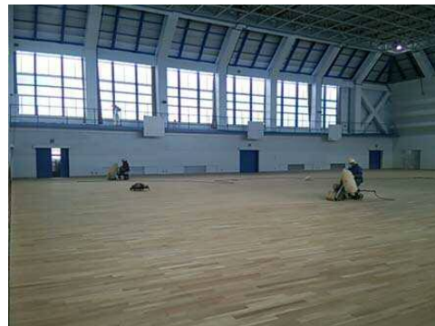
【図 2-4】体育館の床改修の様子
