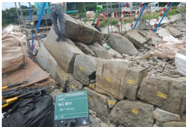
図 91 名古屋城石垣の整備
