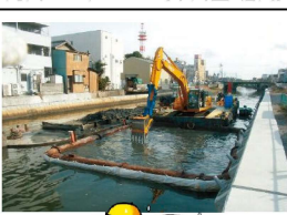
河川のしゅんせつ（中川区 堀川）
