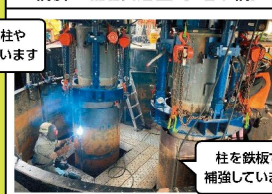
橋脚の補強（港区 小碓中橋）
