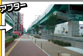
無電柱化（中川区 江川線）事業後
