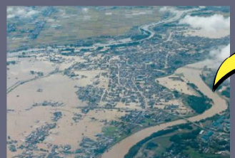
河川堤防の決壊（平成27年 鬼怒川）
