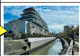
護岸の整備（西区 堀川）
