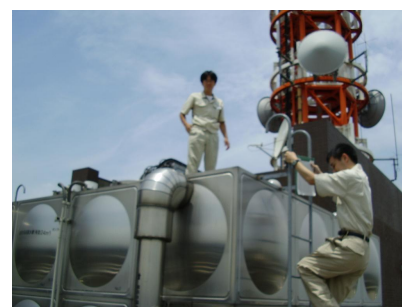
高層建築物における高置水槽の立入検査
