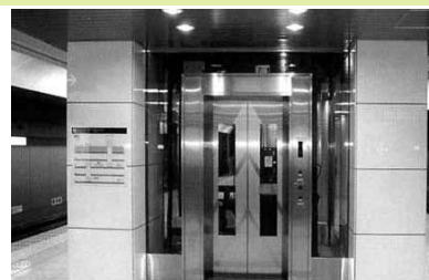
地下鉄駅エレベーターの整備
