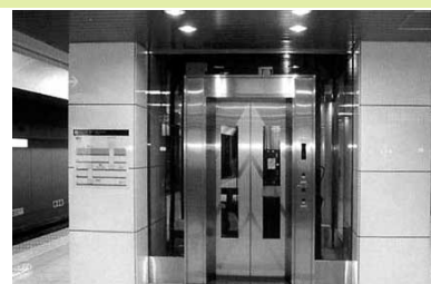
地下鉄駅エレベーターの整備
