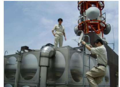
高層建築物における高置水槽の立入検査
