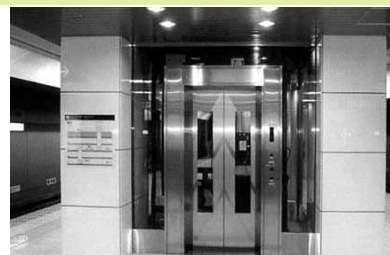
地下鉄駅エレベーターの整備
