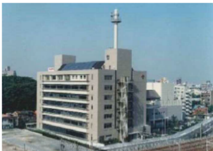
竣工当時の熱田区役所庁舎 (平成13年から)
