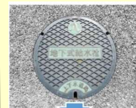
マンホール内部
