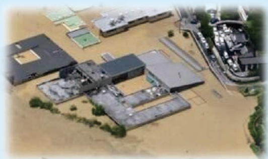
令和 2 年 7 月の球磨川流域の豪雨により、浸水した要配慮者利用施設
