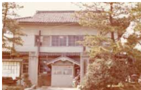
昭和区役所天白支所旧庁舎（地藏寺境内）（昭和45年頃）
