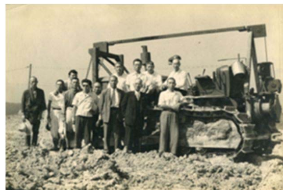
53 平針小学校造成工事開始 (昭和29年)
