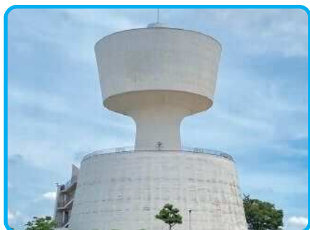
M 鳴海配水塔
