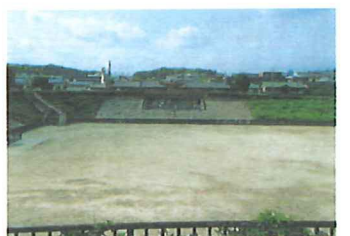
4 扇川公園 (雨水調節池)
