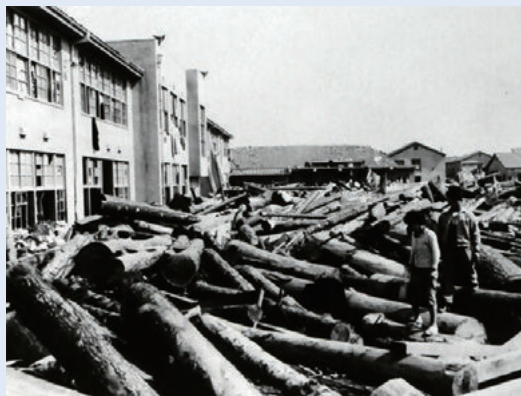
伊勢湾台風で被災した旧白水小学校分校 (現在の柴田小学校)
