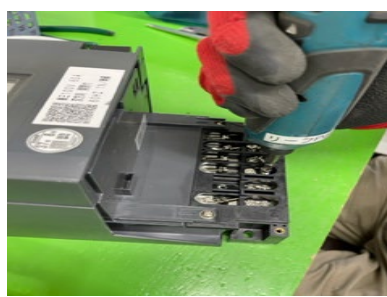
電気メーター解体作業
