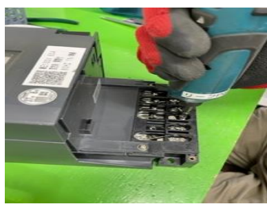
電気メーター解体作業
