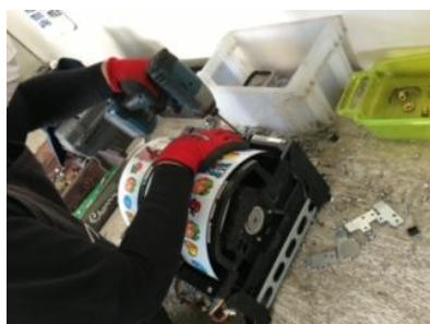
パチンコ・パチスロ解体作業
