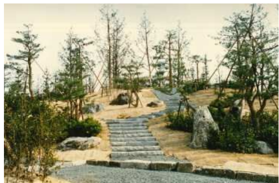
庭園築造工事 （昭和６２（１９８７）年頃）
