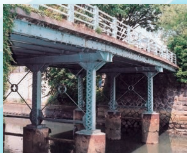
リベット工法の橋脚が残る中橋*
