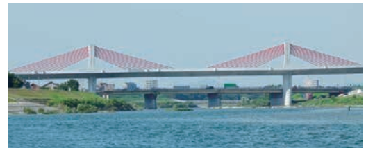
名古屋高速6号清須線の庄内川に架かる赤とんぼ橋
