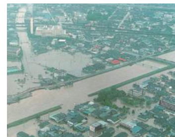
新川破堤地点付近
