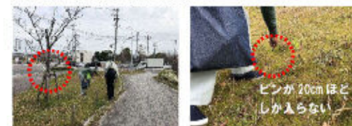
写真⑤ サクラの新植(土壌不足)
