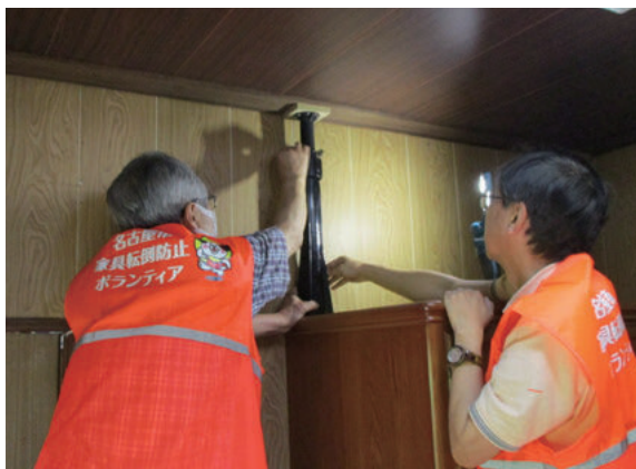
家具の転倒防止作業
