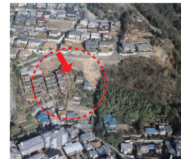
滑動崩落に伴う被害
