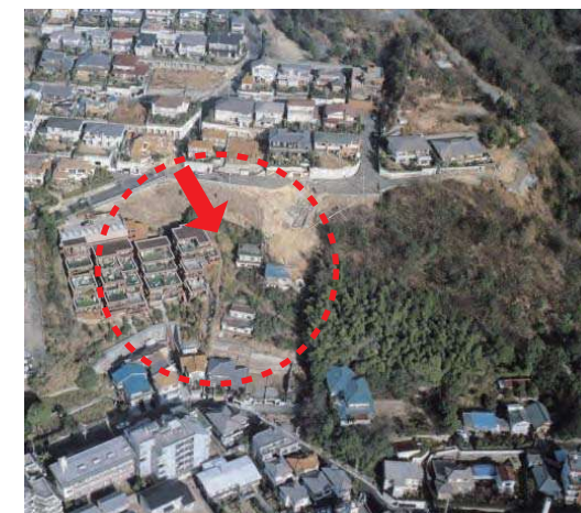
滑動崩落に伴う被害 (宅地耐震化の取組に関するパンフレット：国土交通省)
