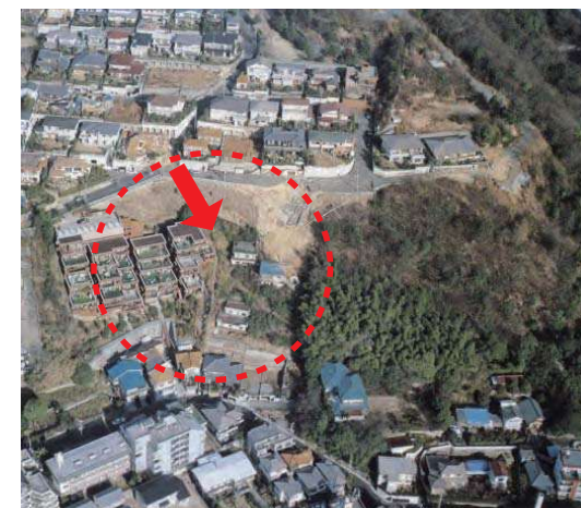
滑動崩落に伴う被害 （宅地耐震化の取組に関するパンフレット：国土交通省）
