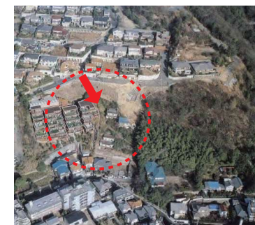
滑動崩落に伴う被害
